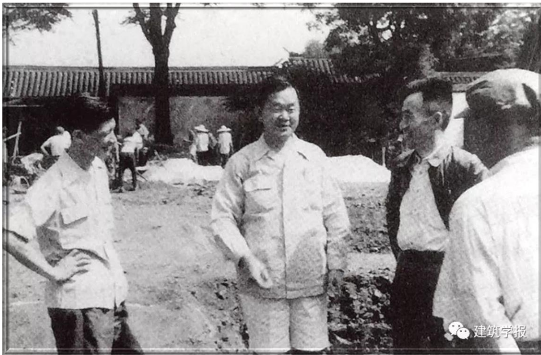
1952年 -- 楊寬麟(中)與楊廷寶(右二)一起視察了和平賓館的建築工地 Young Qua-Ling (center) inspected the construction site of The Peace Hotel with Yang Ting-Pao (right 2) (1952)
