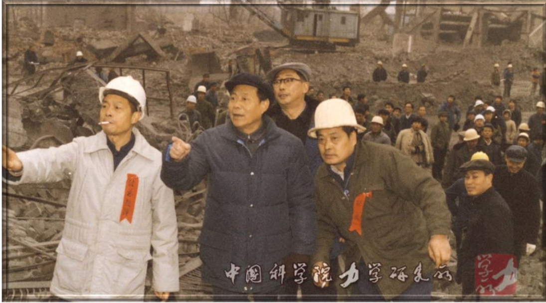
1984年 — 鄭哲敏(左2)視察北京石景山電廠爆破拆除現場
