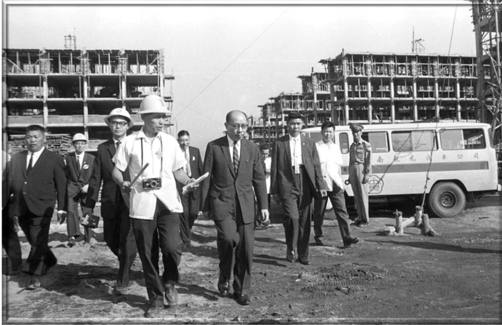
1964 年 5 月 22 日 -- 中華民國行政院長嚴家淦（右一）和臺灣省政府主席黃杰 前往臺北市南機場平民住宅工地，巡視施工情形。（圖／聯合報）
