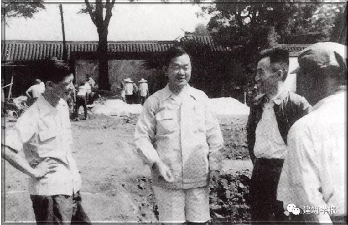
1952年 -- 楊寬麟(中)與楊廷寶(右二)一起視察了和平賓館的建築工地 Young Qua-Ling (center) inspected the construction site of The Peace Hotel with Yang Ting-Pao (right 2) (1952)
