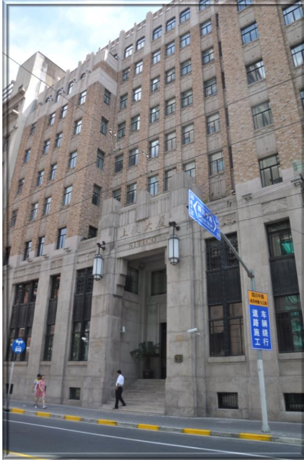
1932 年建成的大陸銀行大樓 -- 現為上海國際信託有限公司上投大廈（上海市黃浦區九江路 111 號）。 Continental Bank Building, Shanghai International Settlement (1932)
