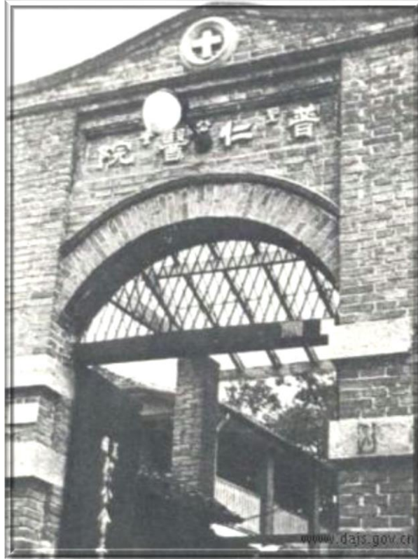
無錫普仁醫院大門 (1930 年) Main entrance of St. Andrew's Hospital, Wusih (1930)
